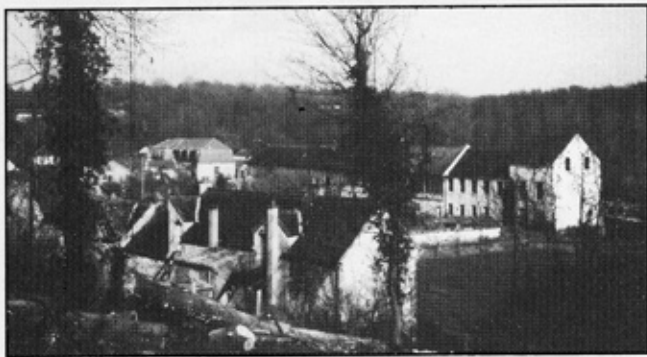
Vue générale des Papeteries du Marais
